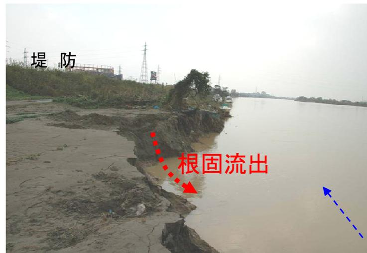
根固めの流出による侵食の拡大
